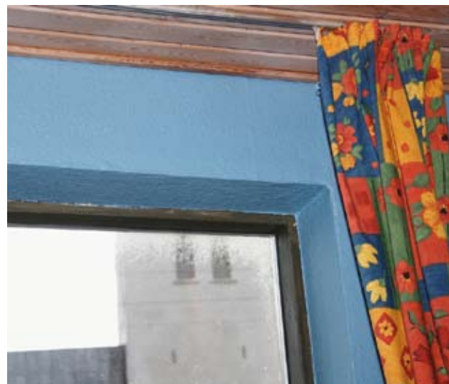
Reparer lister og fuger omkring vinduer og døre – selv små revner giver træk og koster på varmeregningen.
