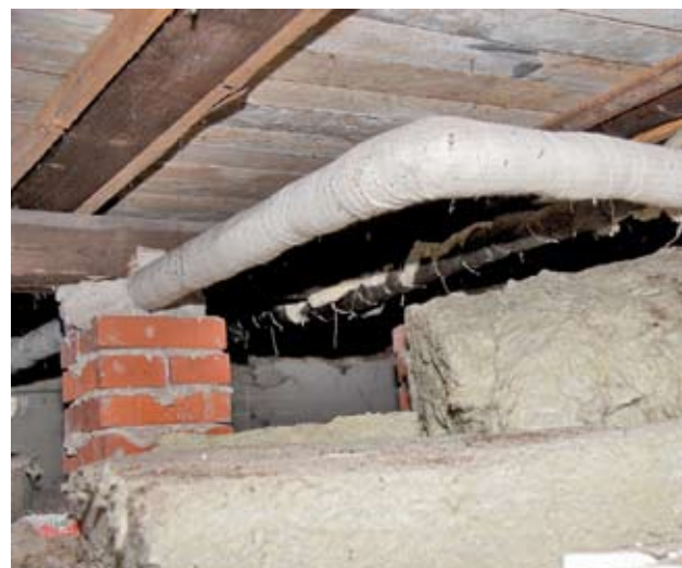
Uisolerede varmerør sender store mængder varme ud i omgivelserne – en temmelig uøkonomisk måde at varme kælderen op på.
